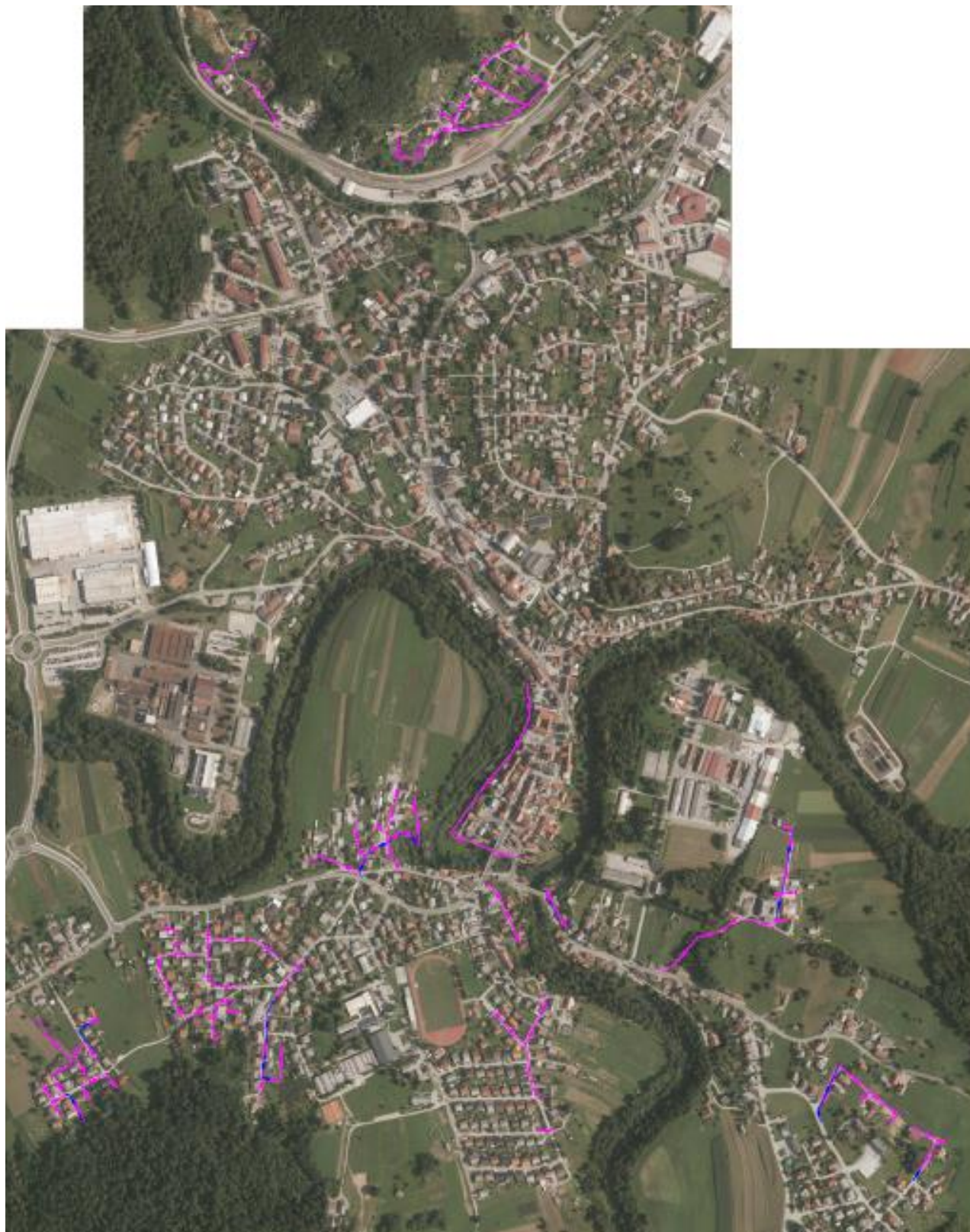
Slika: lokacija novogradenj kanalizacije v mestu Črnomelj
