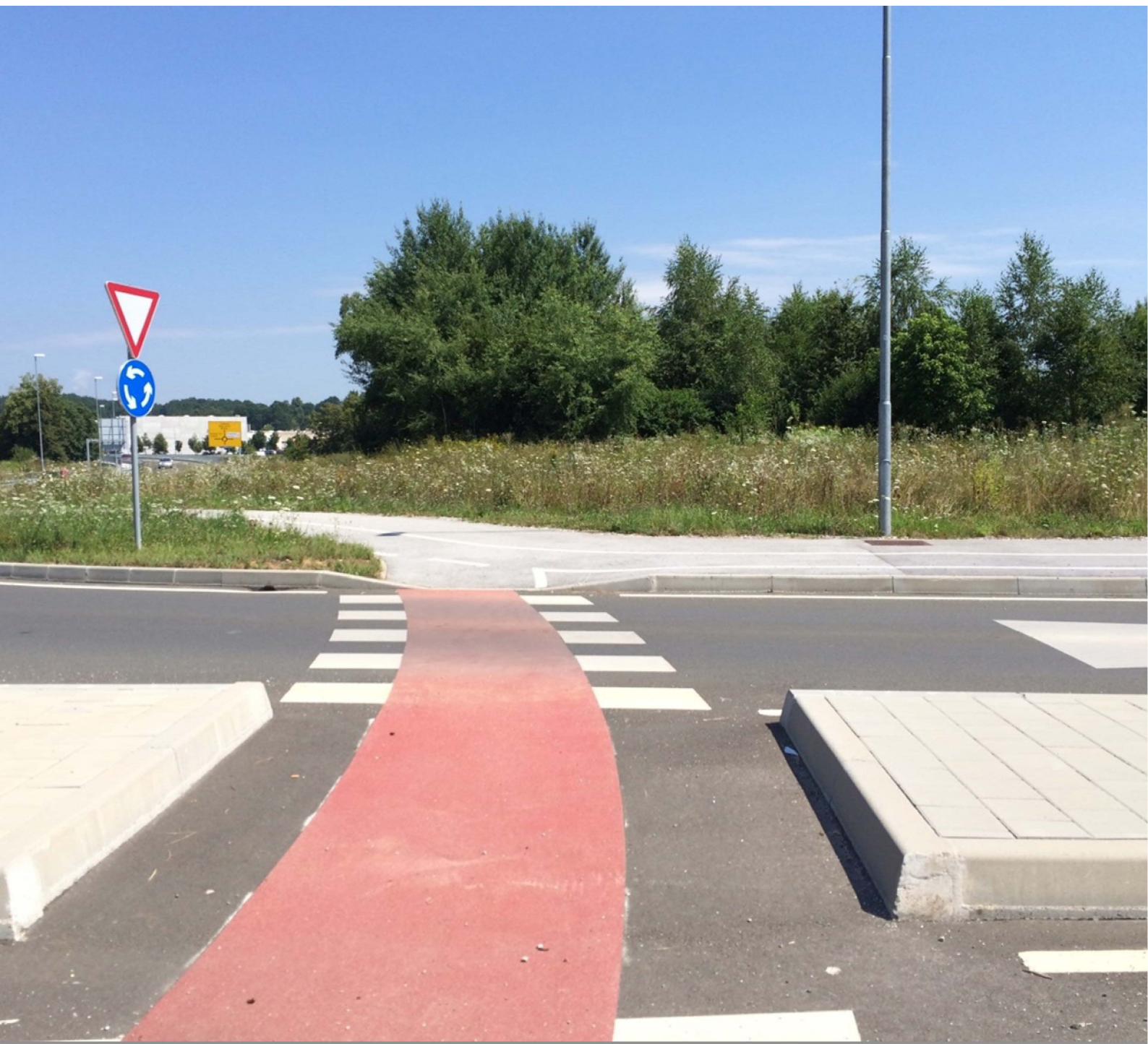
Kolesarska infrastruktura na novozgrajeni obvoznici.
