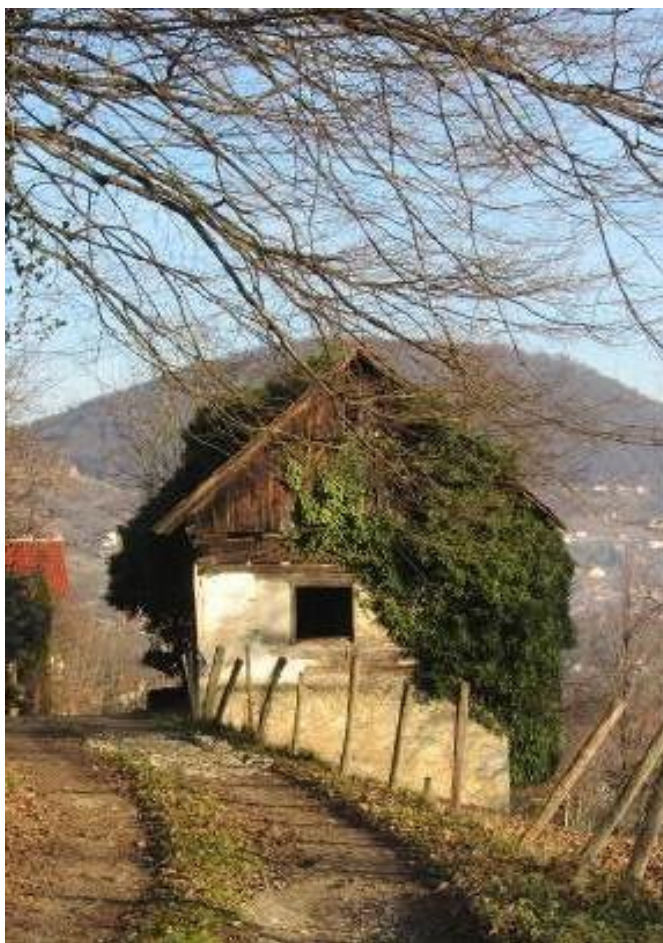
Slika 10: tradicionalni objekt v Ručevski gori- zahodno od železnice
