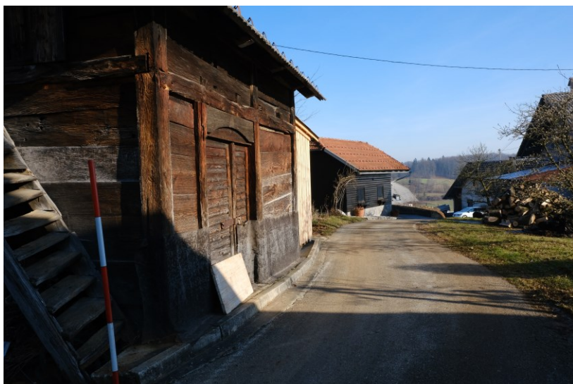
Slika 11: tradicionalni objekt v Ručetni vasi, posebnost - višinski gabarit
