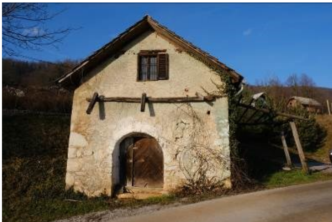
Slika 9: tradicionalni objekt v Ručevski gori- vzhodno od železnice
