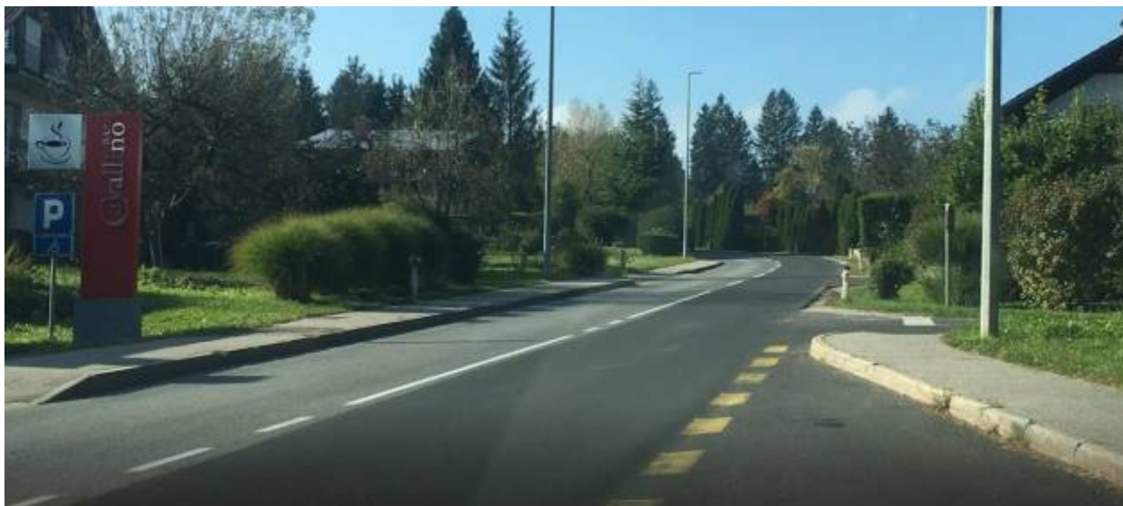
Slika 12: Pogled na začetek Odseka 4 predvidene kolesarske povezave
