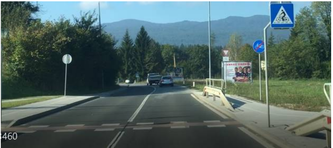
Slika 6: Konec obstoječe kolesarske povezave ob regionalni cesti R1-218/1394
