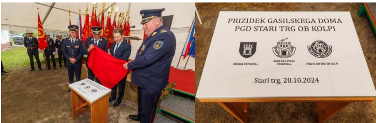
Polaganje temeljnega kamna prizidka gasilskega doma PGD Stari trg ob Kolpi
