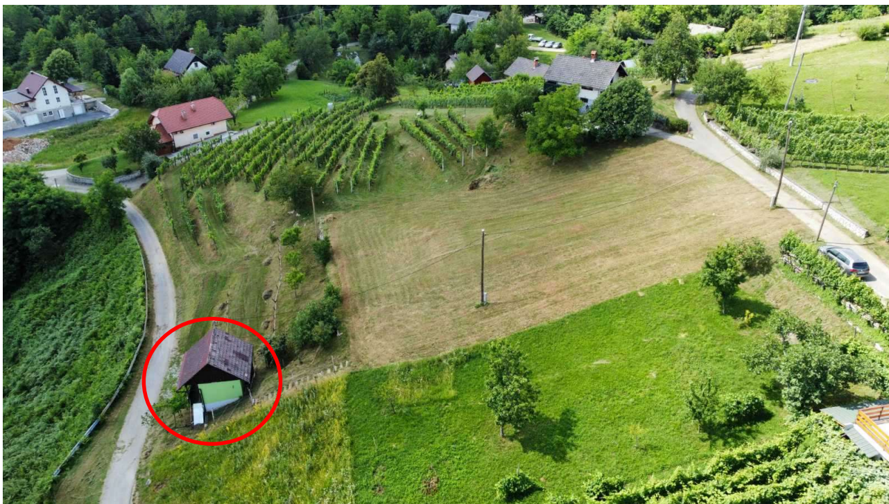
Slika 5: Pogled na objekt s severne smeri. Foto: Investitor, 2023.
