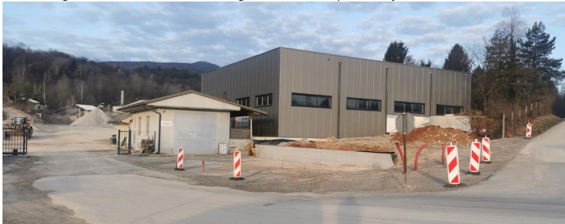
Slika 5: Pogled na vhod v kamnolom z regionalne ceste, upravni objekt ob vhodu in skladiščni ob njem
